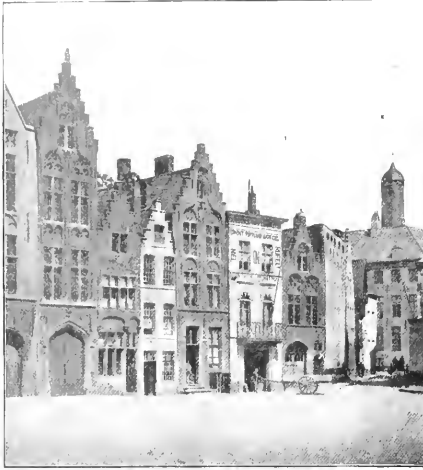
Maisons Place Van Eyck à Bruges.
