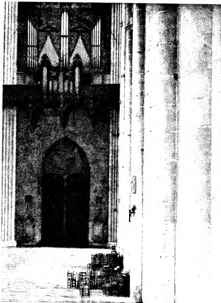
Fig. 30. — NEF DE LA CATHÉDRALE D'AMIENS. — Côte Nord, la 3 e pile au troisième pilier à partir du pilier montrant que ce pilier ainsi que les piliers voisins sont verticaux de la base au chapiteau. Journal of the Royal Institute of British Architects, Vol. XV, d'après un agrandissement photographique du Musée de Brooklyn, série de 1907.
