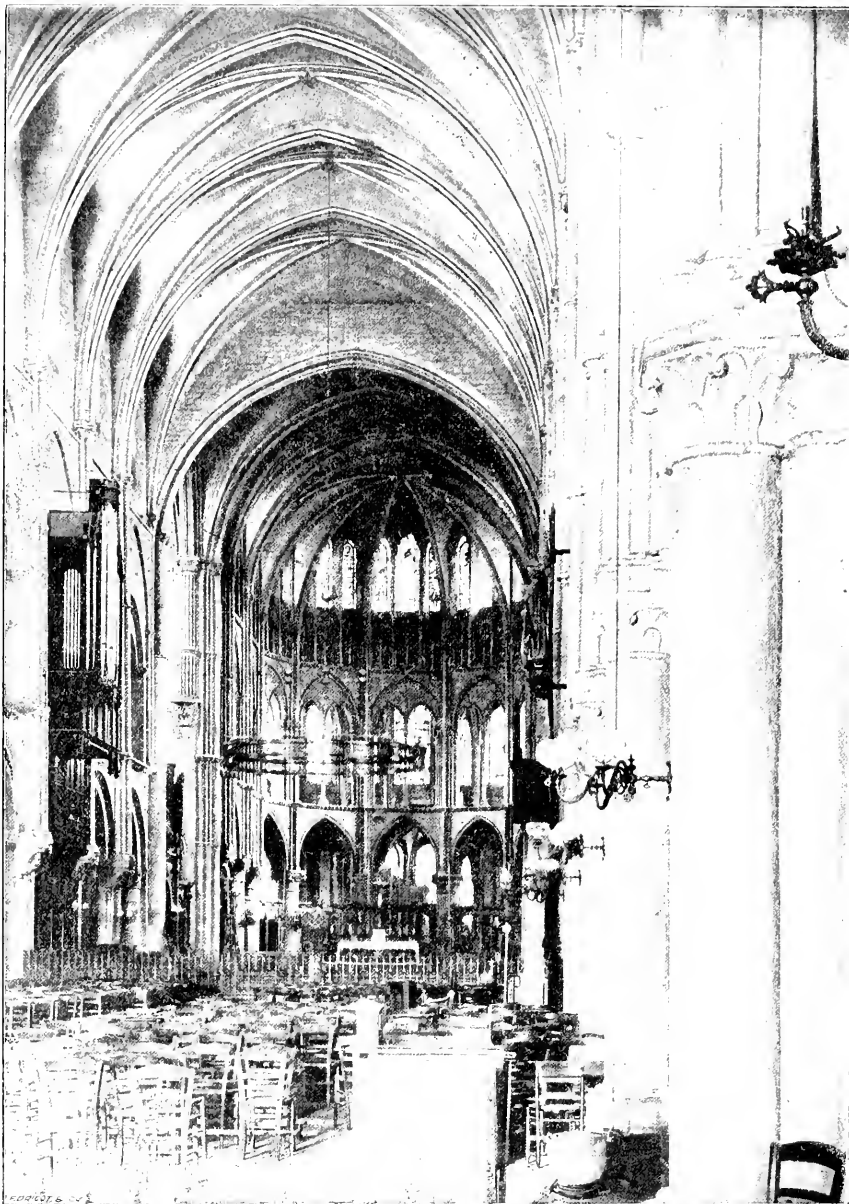
Fig. 6. — NEF DE SAINT-REMI DE REIMS. — Fil à plomb descendant du triforium, montrant que le pilier voisin est vertical de la base au chapiteau et que l'inclinaison de la colonnette de la voûte haute commence au chapiteau. Au pied du pilier dans le plan de mesurage se trouve un voyant de mire de 0 m ,20 - 0 m ,25. Le fil à plomb indique également que les colonnettes à travers la nef s'inclinent en ligne droite à partir et au-dessus des chapiteaux x. (D'après un agrandissement du Musée de Brooklyn, série de 1907).
