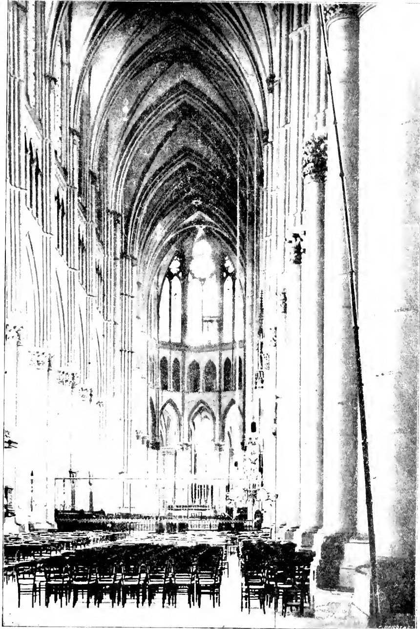
Fig. 1. — NEF DE LA CATHÉDRALE DE REIMS. — Fil à plomb suspendu à une cune à pêche en tambour. On voit le fil à plomb à l'arcade extérieure du pilier auquel est attaché le cruchet et à un autre que le pilier est parfaitement verticalement versé il se quitte au chapiteau. Ce fil à plomb indique aussi la verticalité des piliers, arches et spécialement du pilier suivant sur ce piliers ou post. sur ce fil à plomb jusqu'à la naissance des voûtes hautes et constater que la colonnette s'incline en ligne droite à partir du chapiteau du pilier; la même observation s'applique à la colonnette de la voûte haute au-dessus du pilier, on se trouve appendu le cruchet. Au pied de la figure on voit les nœuds qui peuvent servir d'échelle, le voyant circulaire a un diamètre de 0m,14 les autres voyants ont 0m,20 - 0m,25. (D'après un agrandissement du Musée de Brooklyn, série de 1907)
