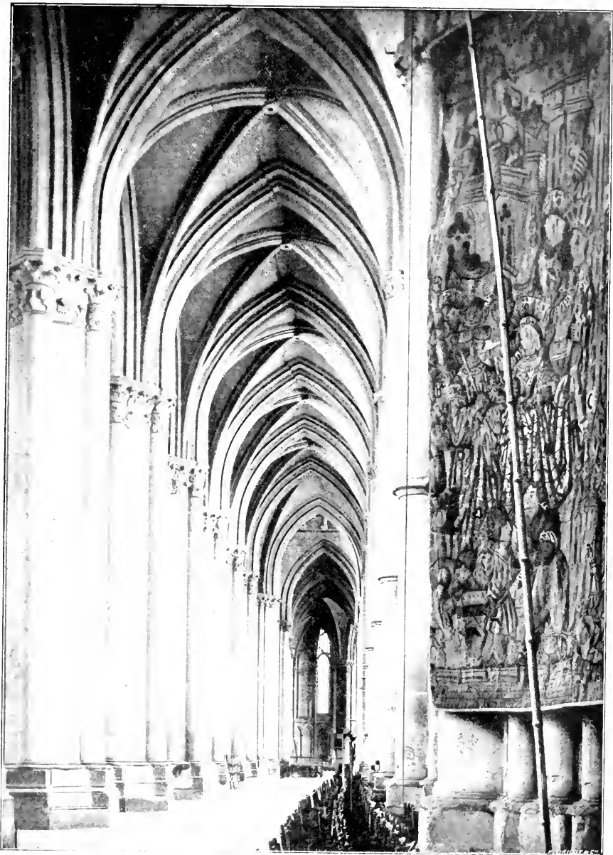
Fig. 6. — CATHÉDRALE DE REIMS, bas-côté gauche. — Fil à plomb suspendu à une chaîne, pèse en l'air ou montre l'inclinaison d'un dossier. Le voyant de mire circulaire dans le plan de mesurage pour ce dossier a un diamètre de 0,14. Cette photographie montre également que les piliers de la nef sont verticaux. (D'après un agrandissement du Musée de Brooklyn, série de 1907).
