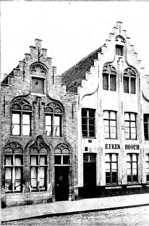
Maisons du Marché au Fil à Bruges.
