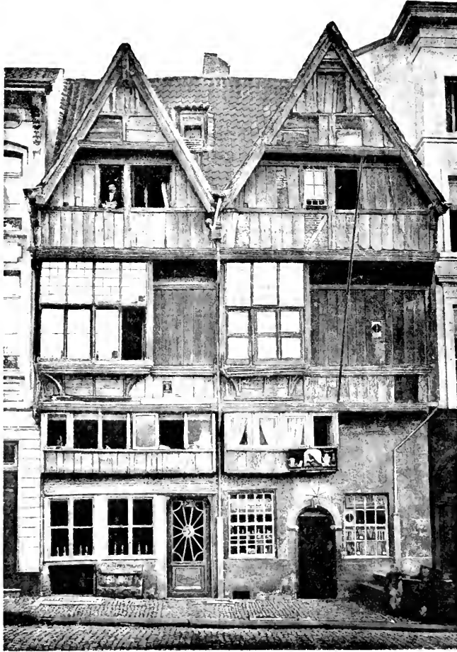
Deux des quatre pignons de la place Sainte-Walburge à Anvers (D'après VAN VESSEL, Documents 1881, p. 101).
