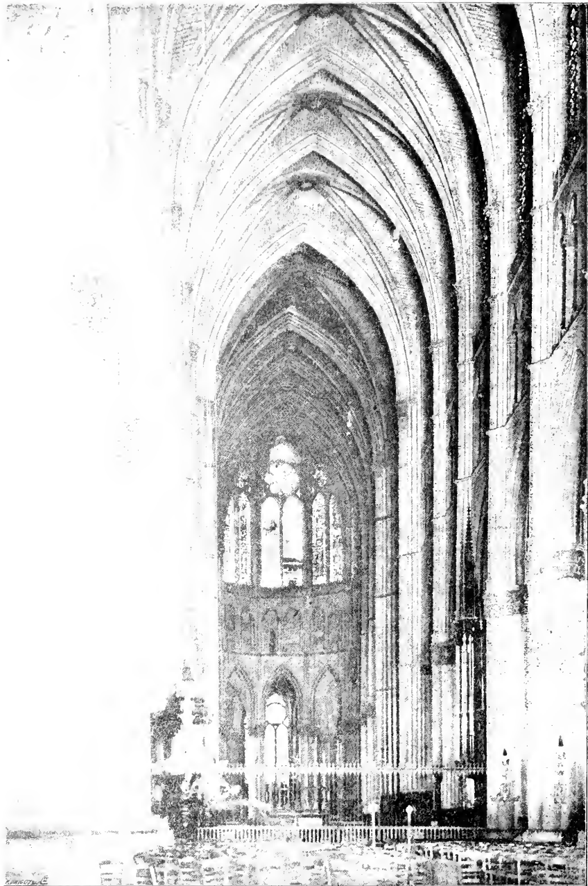
Fig. 2. — CATHÉDRALE DE REIMS, côté droit de la nef. — Fil à plomb descendant du triforium sur le pilier voisin de la chaire à prêcher. Dans l'axe de la nef se trouvent deux nefs; la première se trouve au droit du fil à plomb et le voyant a 0 m 14 de diamètre, le second voyant de 0 m 20 à 0 m 25 est placé au droit du pilier contre lequel se trouve la chaire. Le pilier sur lequel se dessine le fil à plomb est vertical de la base au chapiteau. L'inclinaison de la colonnette commence au chapiteau et le fil à plomb se voit jusqu'à la hauteur du cordon sous le triforium. L'inclinaison d'autres piliers peut être constatée par le câble de suspension du luminaire qui se trouve dans le voisinage de la chaire. Au moyen du compas on peut se convaincre facilement à l'aide de ces fils à plomb que les piliers de la nef sont partiellement verticaux jusqu'aux chapiteaux.
