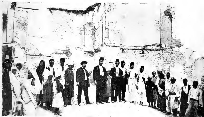
Le Souqaland incendié.
