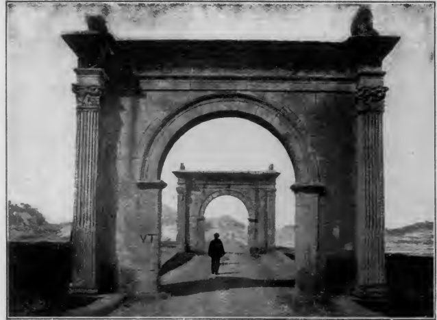
38. Brücke bei St. Thamas in Südfrankreich.
