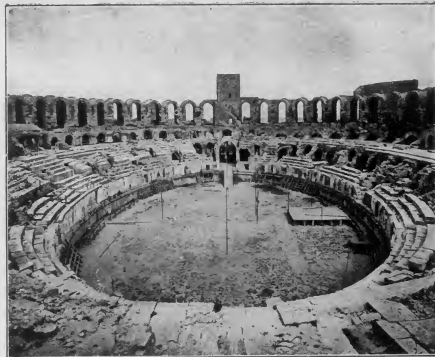
23. Amphitheater, Innenansicht: Arles (Arelate), Frankreich.
