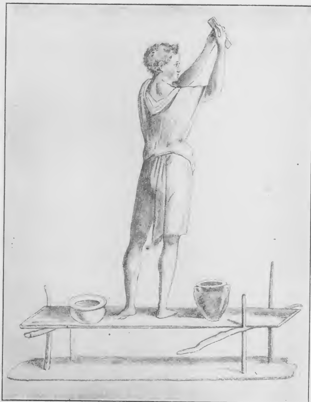
146. Maurer beim Verputzen (tunicare) einer Wand. Wandbild aus Pompeii.
