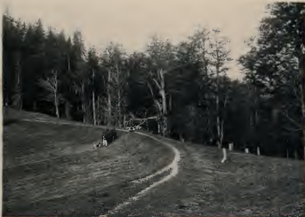
Fig. 16. Damm bei Prskala stajo.
