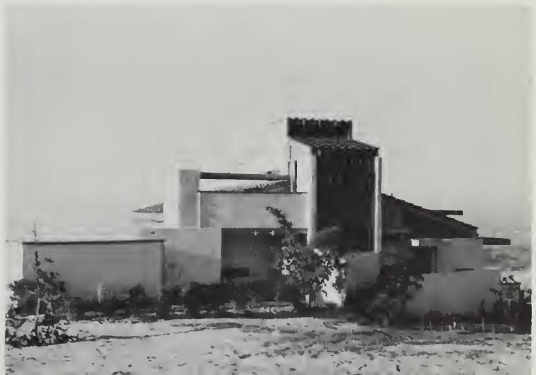
House for H. N. von Koerber, Hollywood Riviera, Torrance, 1931
