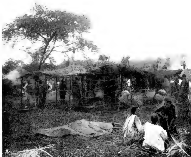
Bau von Schutzdächern in Ibanda.
