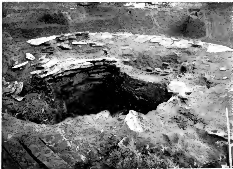
2). Dettaglio della cella pennacchio in aggetto della volta.
