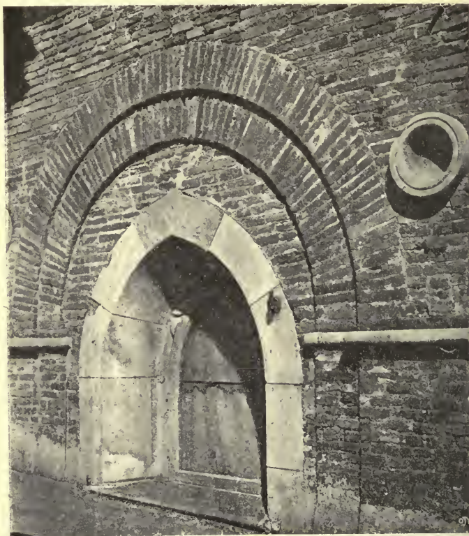
Fig. 5. Finestra del lato meridionale (fot. dell'ing. G. Astorri).
