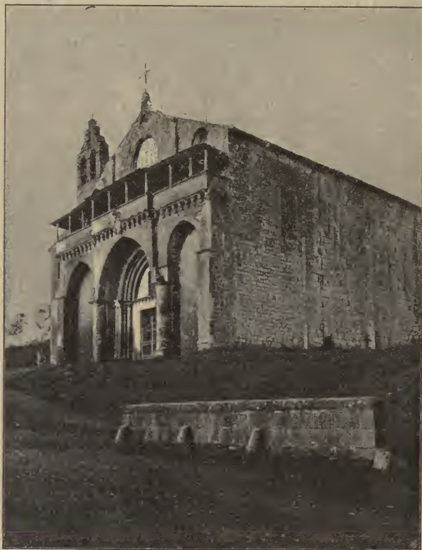
S. Flaviano di Montefiascone: facciata.
