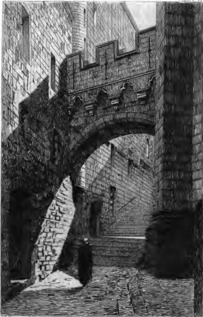
J. Caspary del. L. Cassin sc. PONT PORTIÉ DANS LA COUR DE L'ÉGLISE (RESTAURATION)
