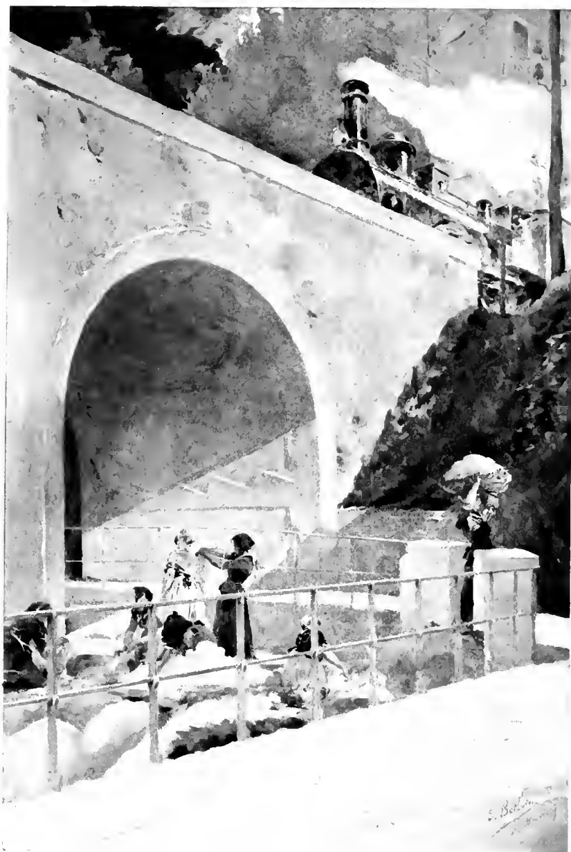
Pont du Chemin de fer sur le Carey à Menton
