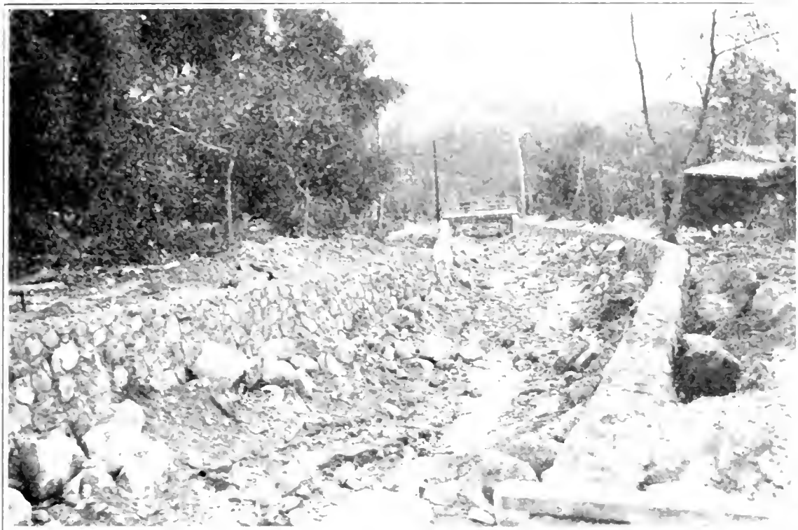
FIG. 33.—Sierra Madre Conduit—rubble wall construction.
