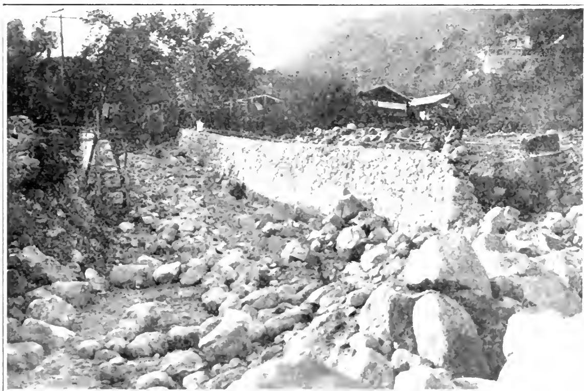
FIG. 34.—Sierra Madre Conduit—rubble wall construction.
