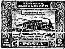
R. R. Bridge Over Kizil Irmak A70
