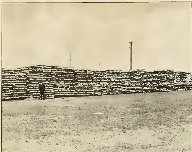
FIG. 1.—TIE YARD, SHERIDAN, WYO., APRIL, 1902—SOLID PILES.
