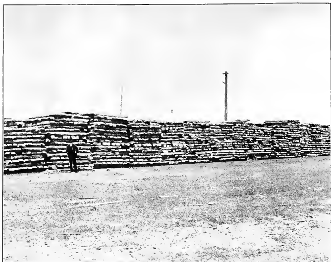
FIG. 1.—TIE YARD, SHERIDAN, WYO., APRIL, 1902—SOLID PILES.
