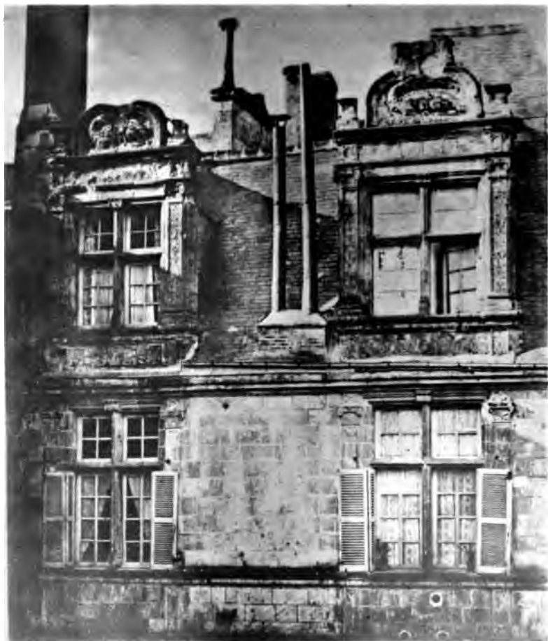
FENÊTRES HAUTES DU PAVILLON DE 1508
