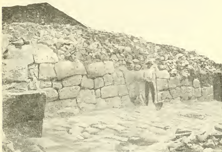
FIG. 5. — Strada e muro di terrazza.
