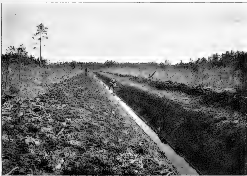
Fig. 4. Hufvudaflopp upptages vid större afdikning af vitmosse för skogsbörd. Vattholma bruk. Vinterväg anlägges samtidigt utmed atloppsgravnen.
