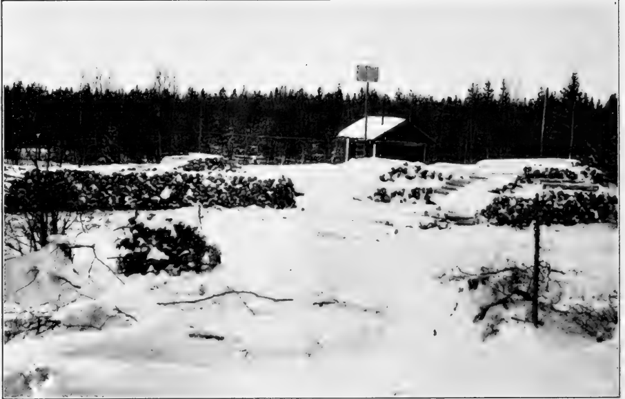
Fig. 6. Insnöad masseved, upplagd för inmätning i löst mått. I och för besiktning och inmätning måste virkestaplarna genom leverantörens försorg befrias från is och snö.
