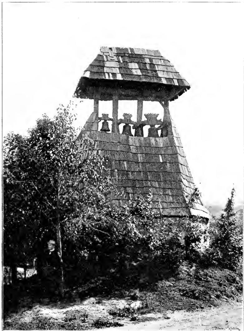
Obr. 123. Neprobílce. Dřevěná zvonice.
