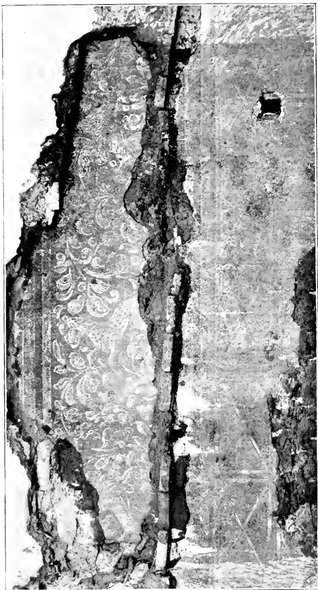
Obr. 4. Bakov. Sgraffita na straně severní.
