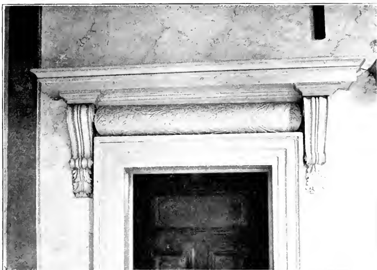
Obr. 113. Nelahozeves. Ostění dveří v zámku.
