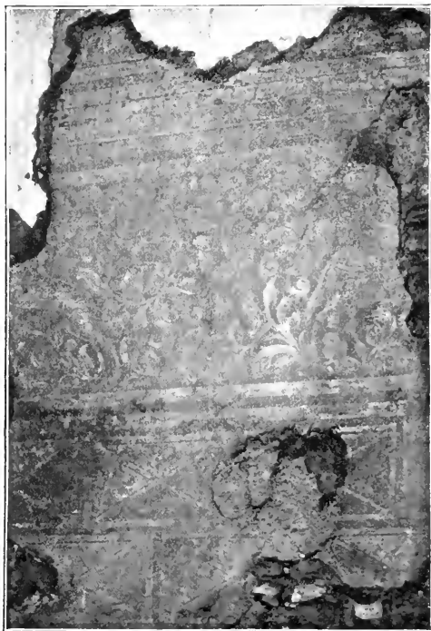
Obr. 2. Bakov. Sgraffita na straně severní.
