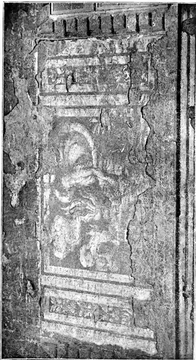
Obr. 307. Nelahozeves. Sgraffita na severní straně zámku.
