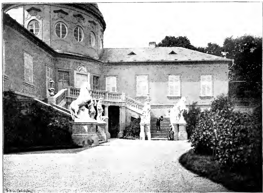
Obr. 250. Veltrusy. Schodiště zámku.
