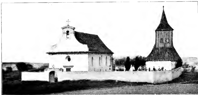
Obr. 94. Libušín. Kostel a zvonice.
