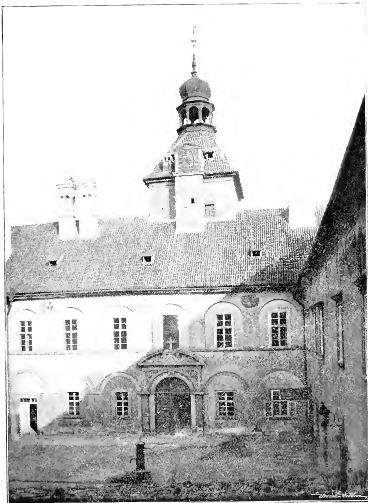
Obr. 206. Smečno. Pohled na východní trakt zámku z nádvoří.
