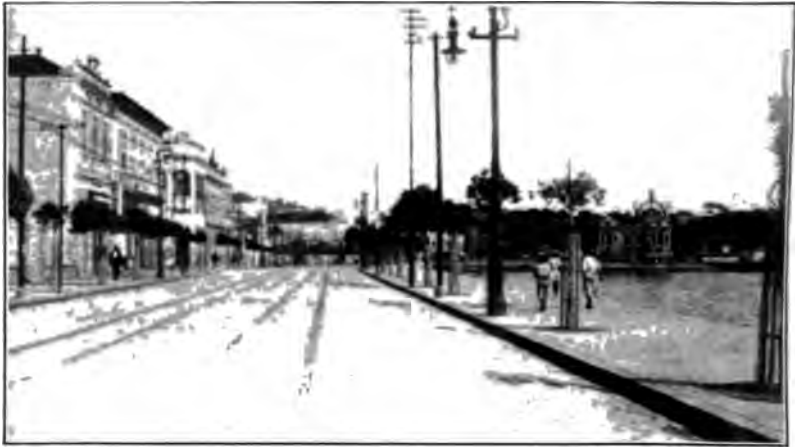
Avenida Beira Mar, Rio de Janeiro
