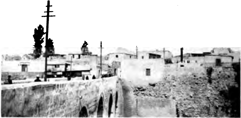
Puente Bolognesi, Arequipa
