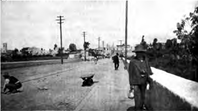
Puente Grau, Arequipa
