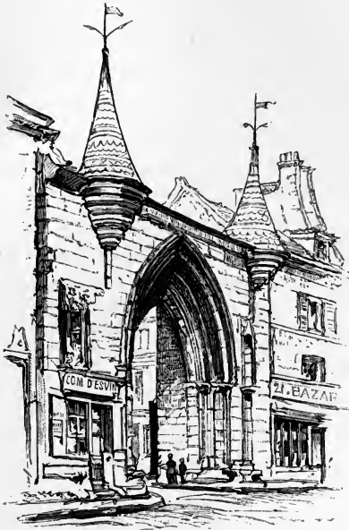
PORTE DU CLOITRE, CORBEIL.
