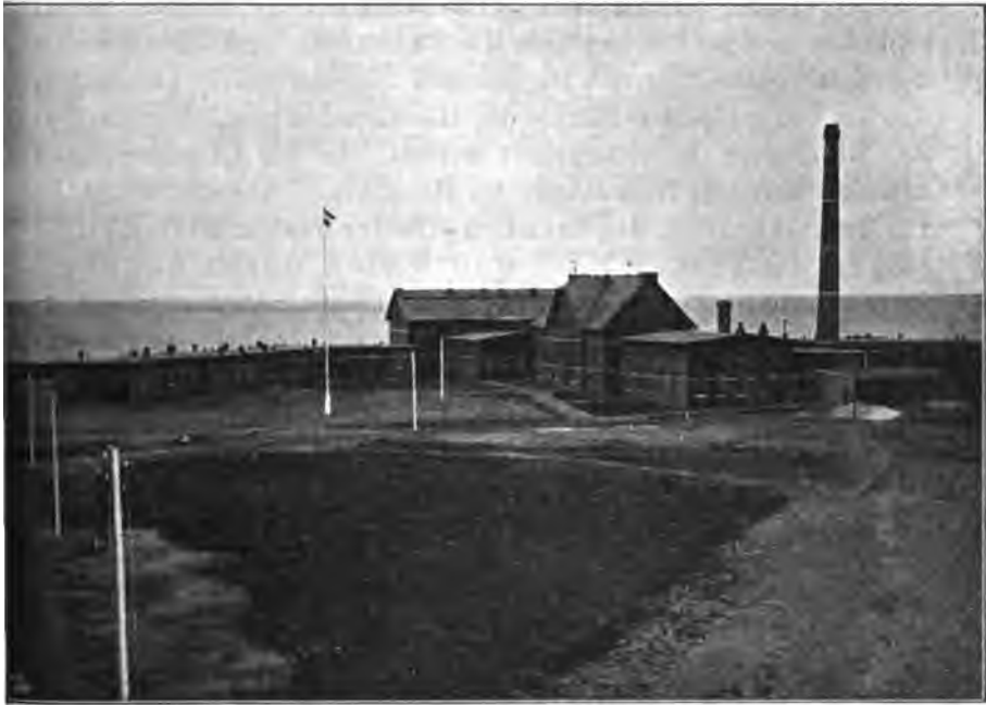
Fig. 1. Ansicht der Anstalt von der Landseite.
