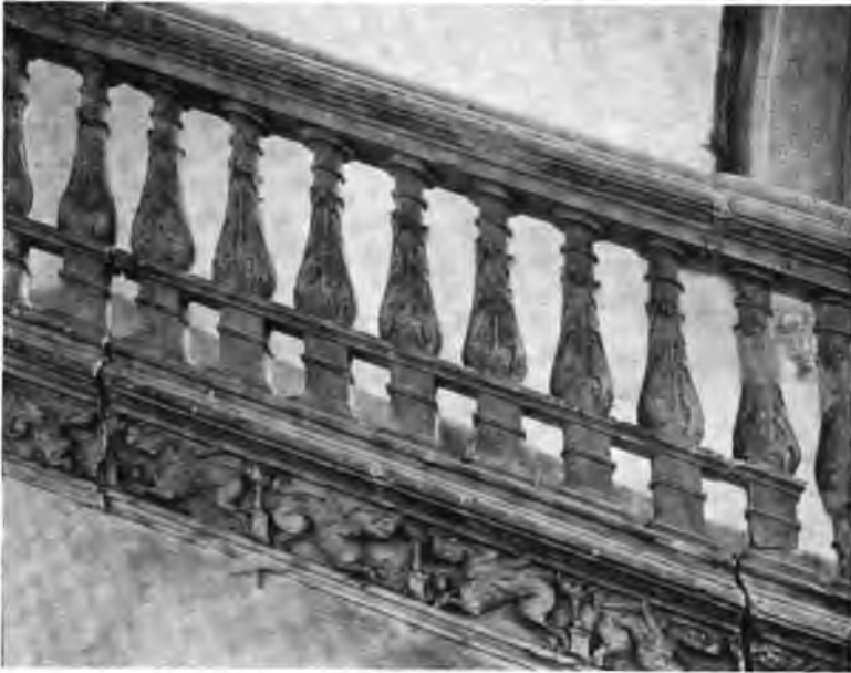
FIG. 63—Detail of Stairway in the Palacio de los Dueños, Medina del Campo.
