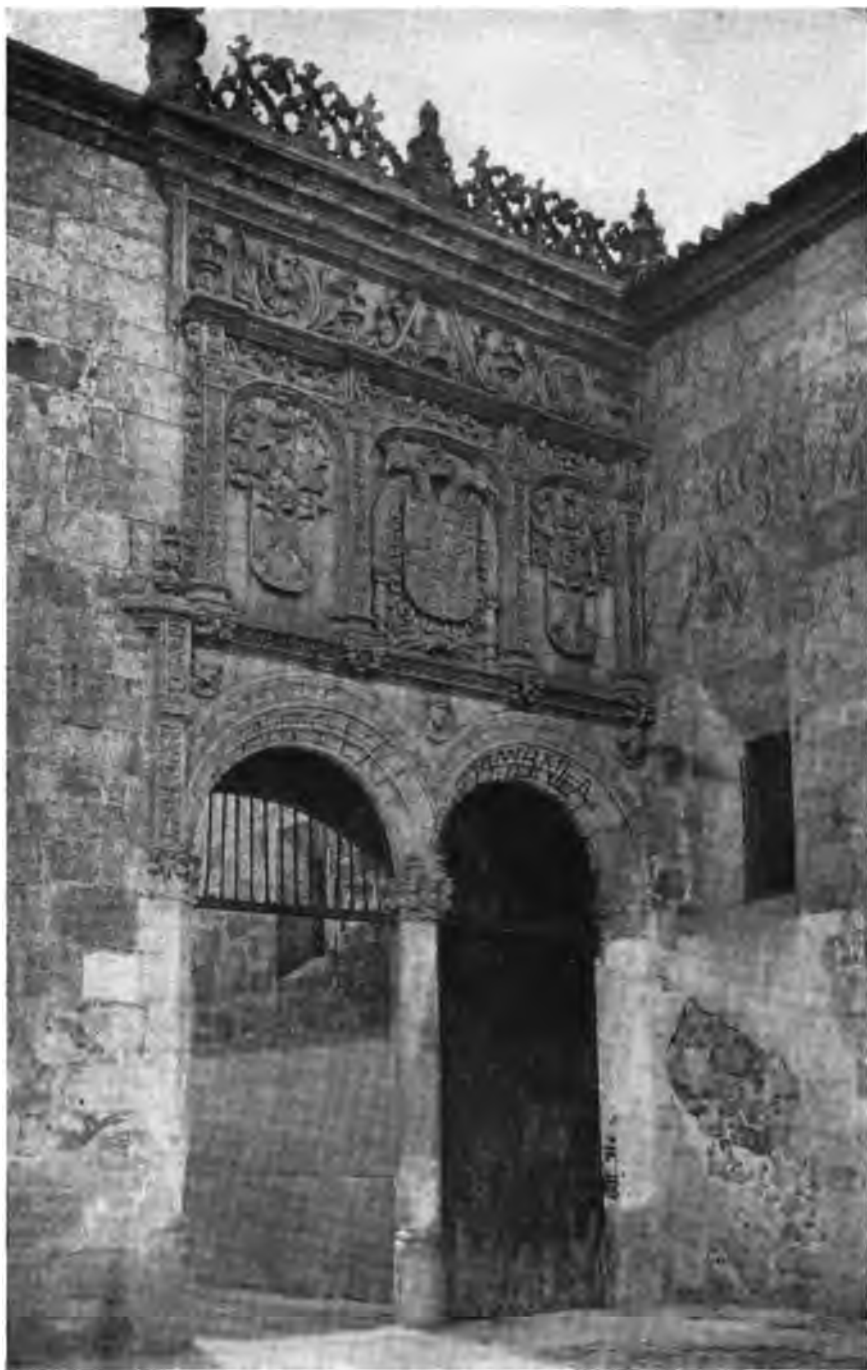
PORTAL OF THE ESCUELAS MENORES, SALAMANCA.
