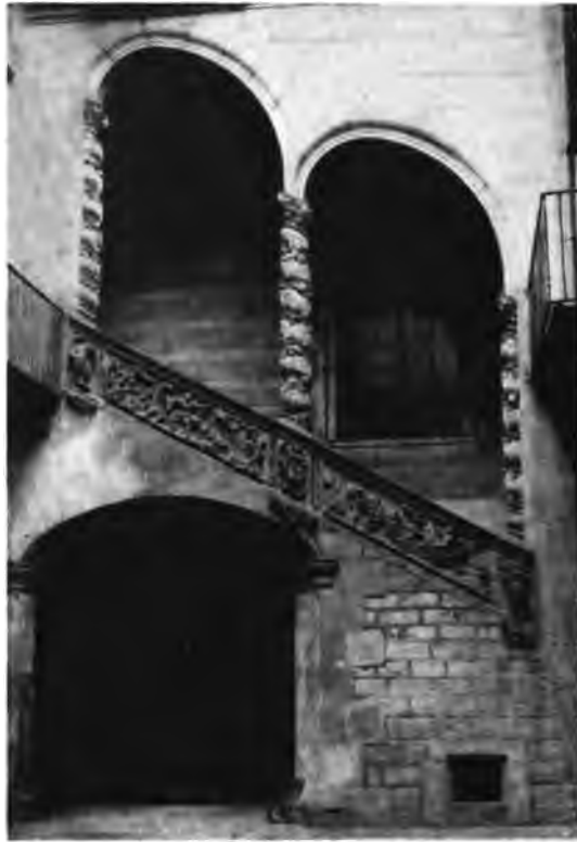
FIG. 118—Stairway in the Palacio de Moncado, Barcelona.
