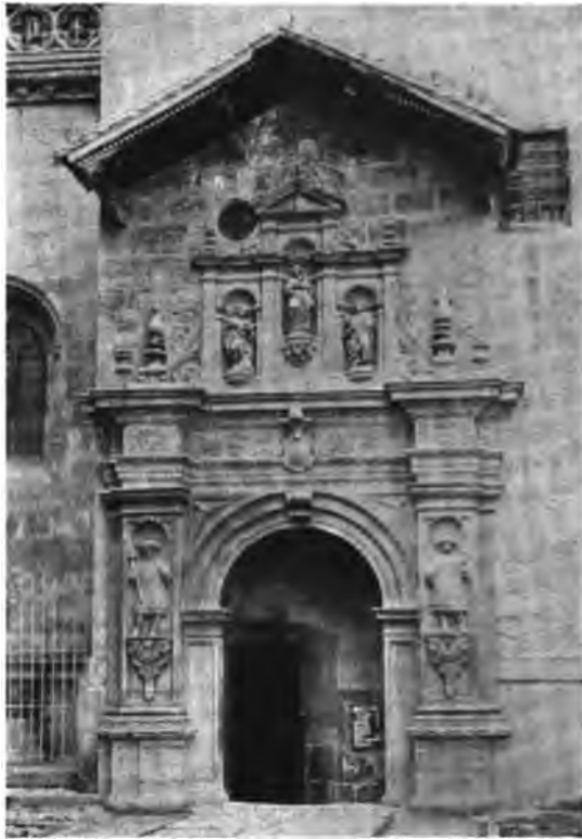
FIG. 93—Portal to the Capilla Real, Granada. Juan García de Pradas, Architect, ca. 1520.
