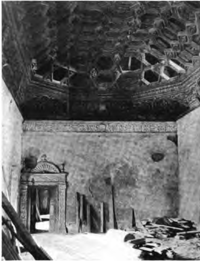
FIG. 39—Wooden Artesonado and Yesería Doorway in the Main Salon at Peñaranda de Duero.
