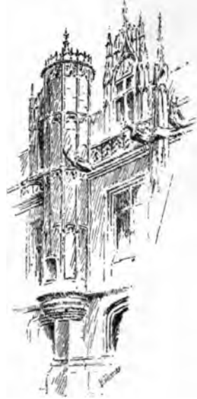
PALAIS DE JUSTICE TOURELLE IN THE RUE ST. LÔ
