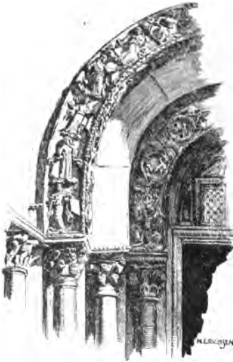
S. MARCO—DETAIL OF MAIN DOOR
