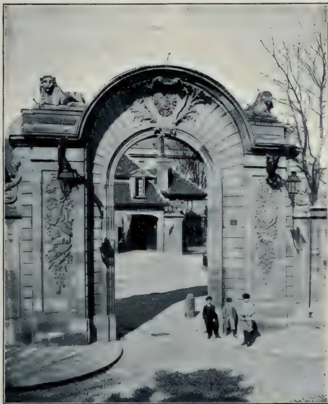
L'entrée de l'ancienne Préfecture.
