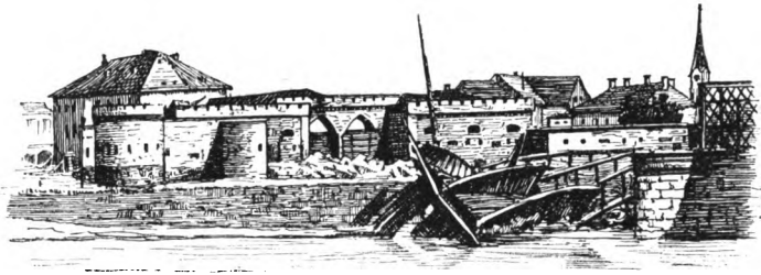
Gesprenge Brücke bei Rehl.
