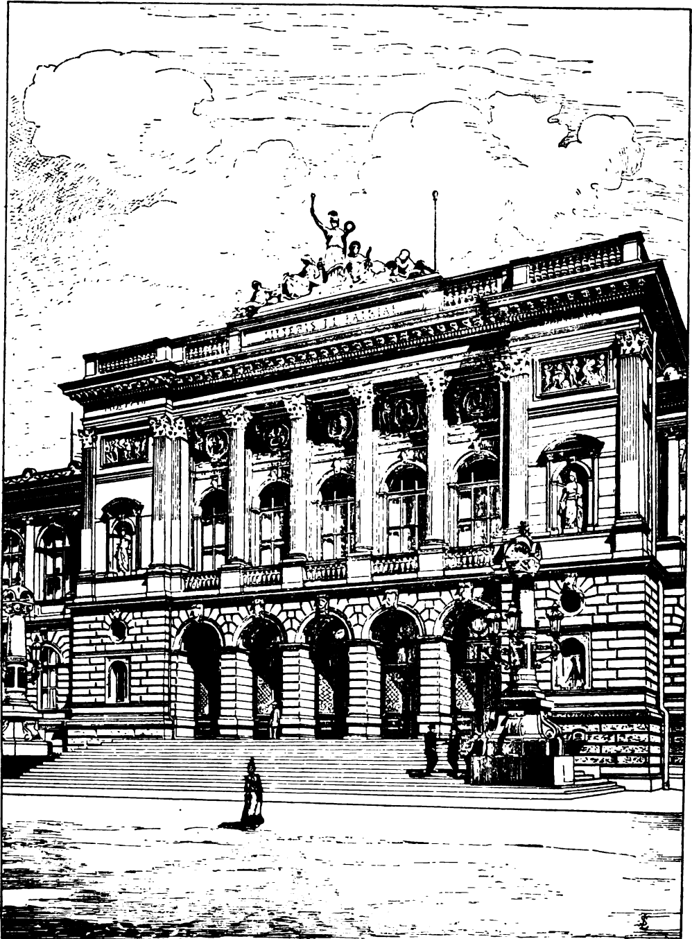
Fig. 357. Allgemeines Kollegiengebäude. Mittelbau.
