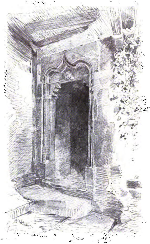
Fig. 181. Schildgasse 2. Eingang zum Treppenthurm im Hofe, gez. von G. Hacker.
