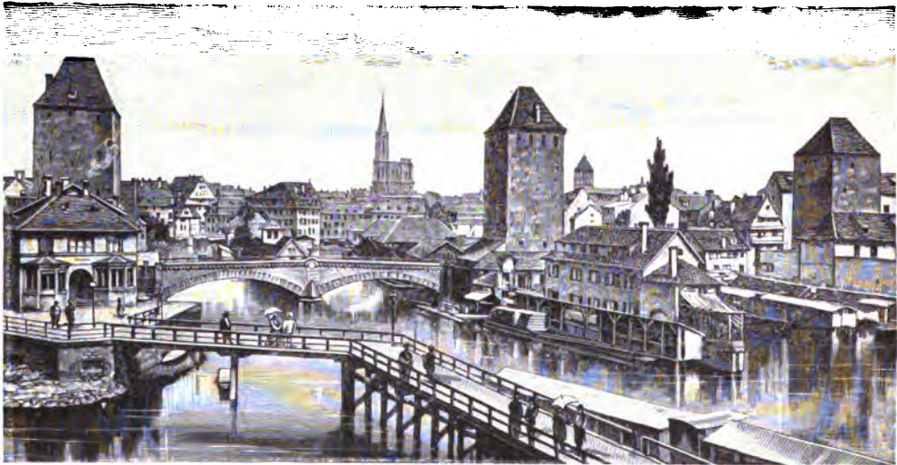
Fig. 60. Die gedeckten Brücken (Aussenseite) im jetzigen Zustand.
