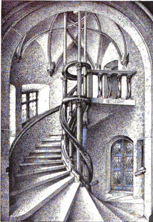
Fig. 164. Frauenhaus. Oberer Theil der Wendeltreppe mit Gewölbeschluss, gez. von J. Knauth.
