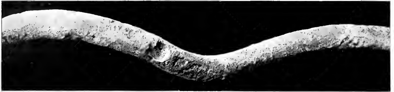
WATER PIPE AT LOS ANGELES.
