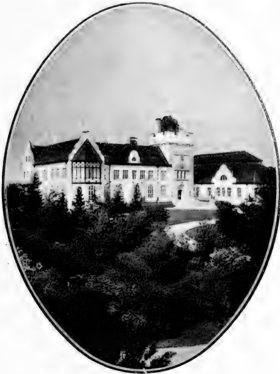
Fig. 11. Institutionsbyggnaden i Svalöf.
