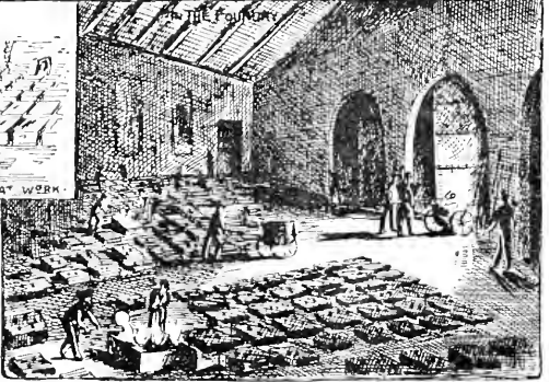
POURING A HEAT
