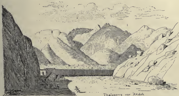
Thalssperre vor 'Akdeh
