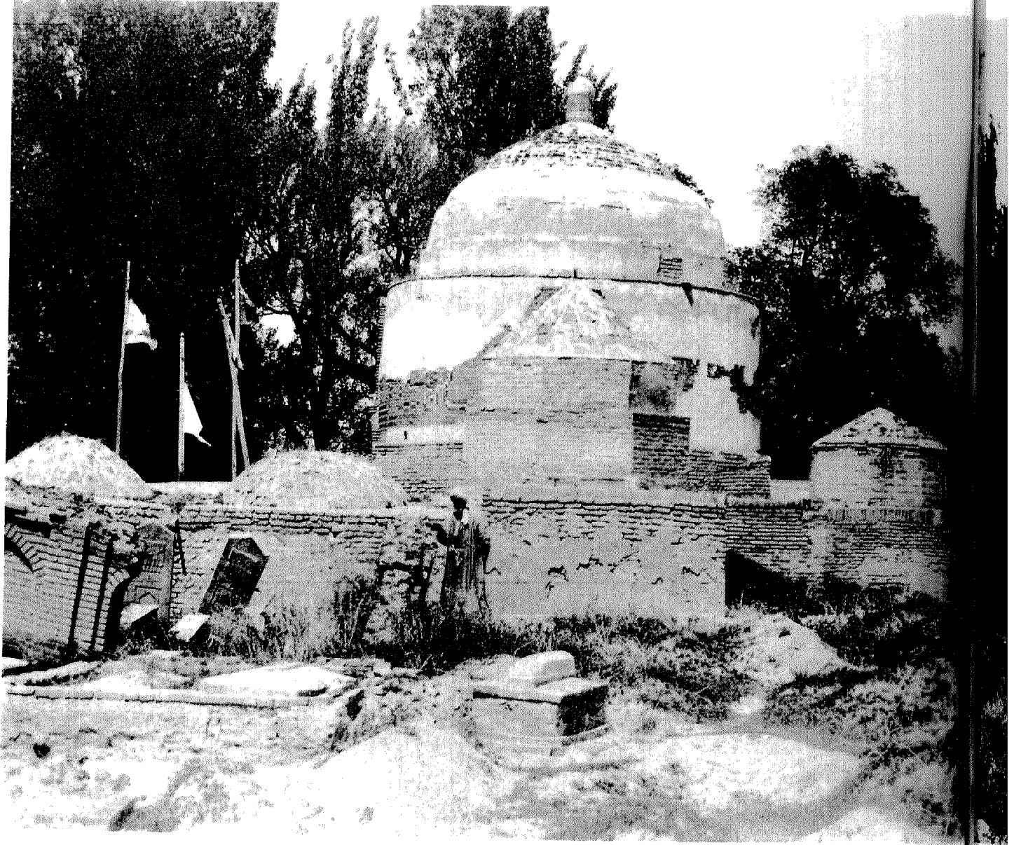
90 مجمع مباني عبد الدارون. منظر للمسجد.
