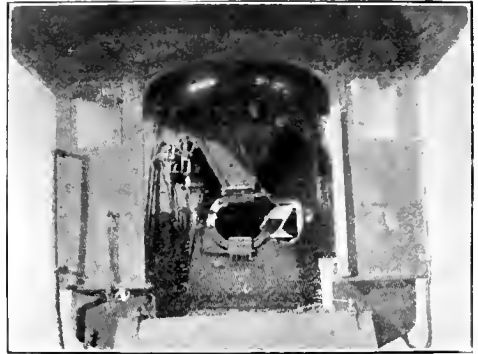
FIRE DOOR OPEN. The Hayden Stoker.
