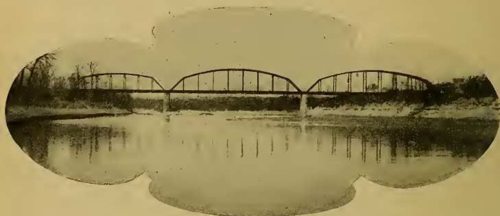
M. K. & T. Ry. Bridge, Red River.
