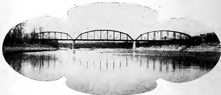
M. K. & T. Ry. Bridge, Red River.
