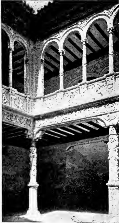
FIG. 203.—CASA DE ZAPORTA: COURTYARD.
