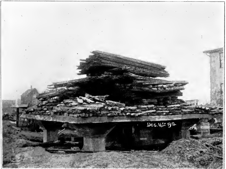
Fig. 16. Mushroom Slab, Load 9.
