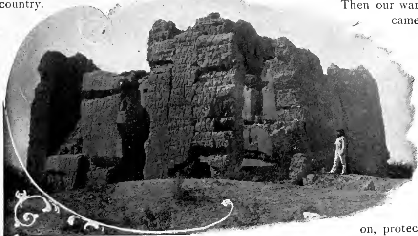
THE CASA GRANDE RUINS IN ARIZONA.
