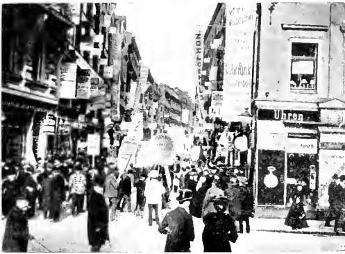
Peterstrasse messun aikana.
