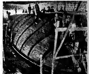
Kuva 3. Käännettävän rautabetonialuksen rakentaminen.
