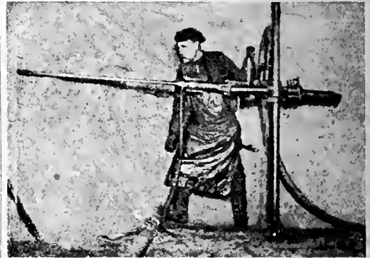
Tunnelia porataan porakoneella.
