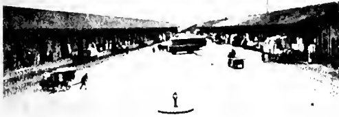
Kuva 11. Varastorakennuksen kadunpuoleinen sivu.
