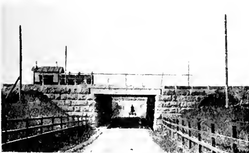
Kuva 13. Maantien alikäytävä Seinäjoen asemalla.
