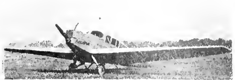
Kuva 7. Kokonaan metallista rakennettu saks. „Junkers” matkustajalentokone.
