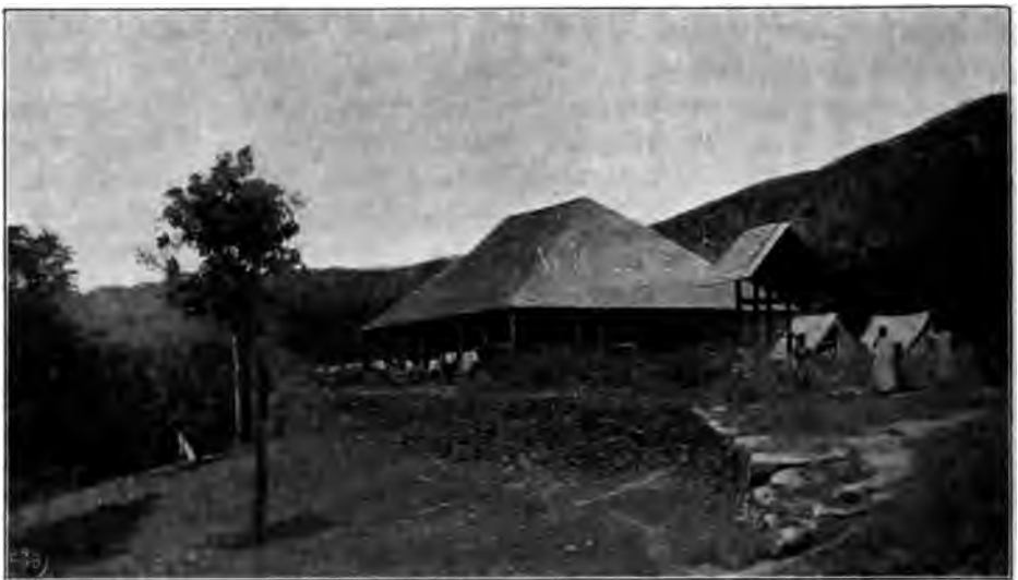
Hauptgebäude der Station Misahöhe.
