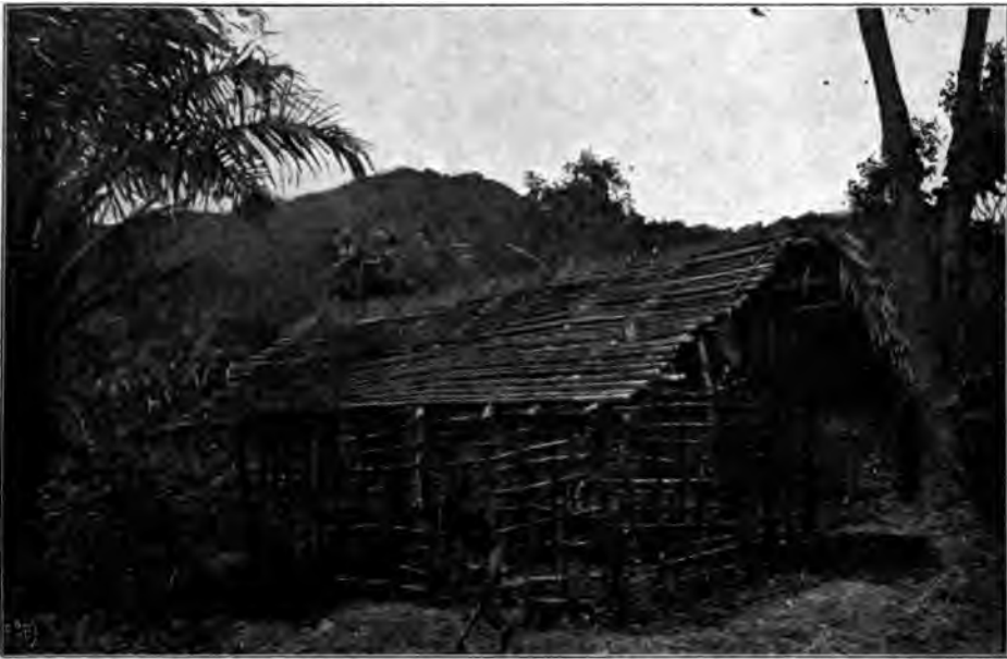
Eine im Bau begriffene Hütte der Evhe-Neger.
