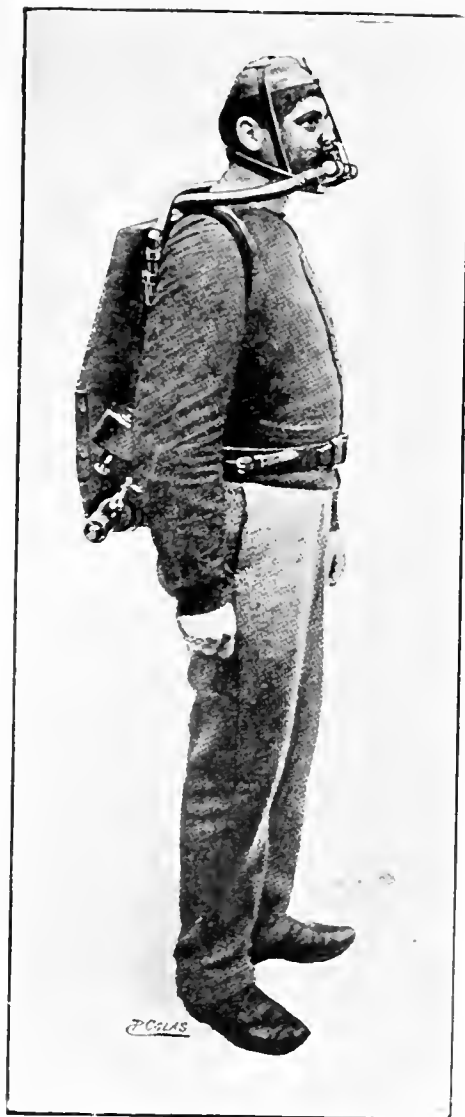
Fig. 2.—Appareil respiratoire du Dr. Tissot qui a servi à l'expérience et qui est appelé à rendre les plus grands services dans les désinfections en raison de la protection parfaite qu'il donne aux opérateurs.
