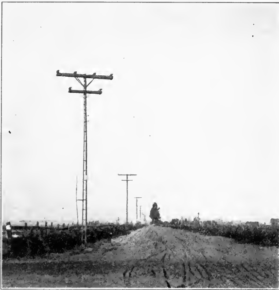
FIG. 21.—Tripartite steel pole line.
