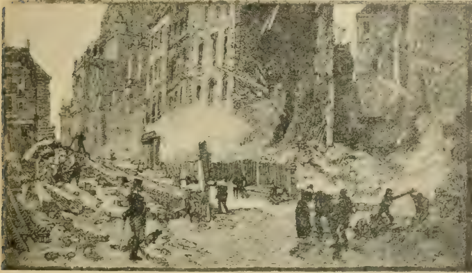
DÉMOLITION RUE SAINT-JACQUES VERS 1880.
