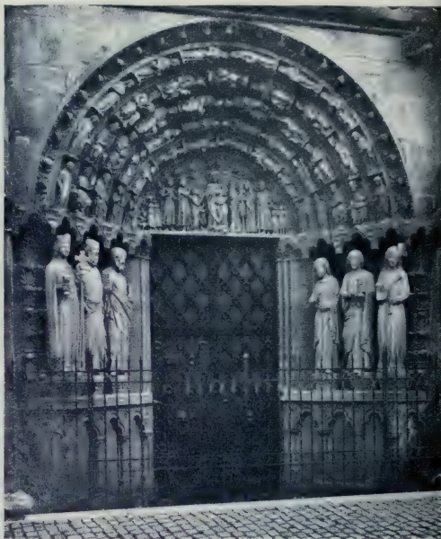
Abb. 82. Portal der Liebfrauenkirche.
