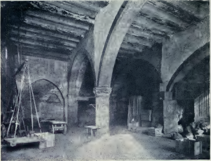
Abb. 101. Ansicht des Erdgeschosses vom Kaufhaus.
