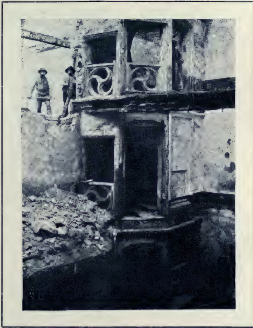
Abb. 104. Treppenturm in dem Faulbeckerschen Hause.
