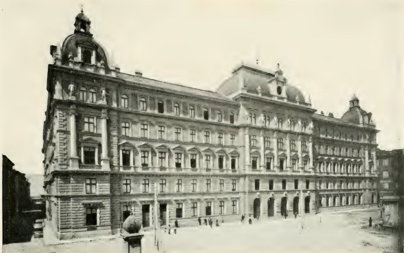
PALAZZO DELLE POSTE.
