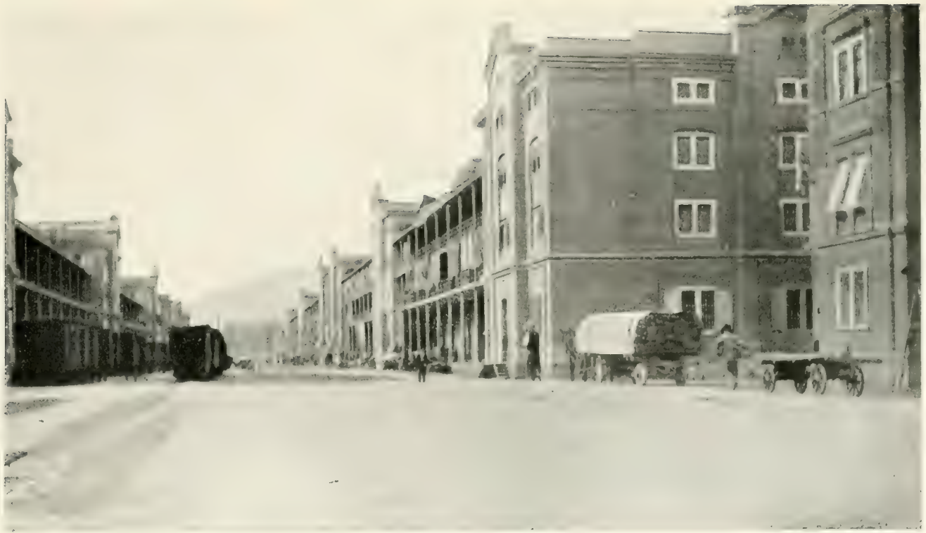
MAGAZZINI DEL PORTO NUOVO.
