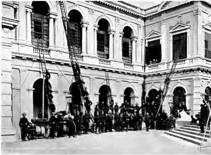
HONGKONG FIRE BRIGADE.
