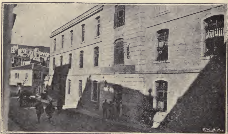
Fig. 1.—Mayer Typhus Hospital, Kavalla.
